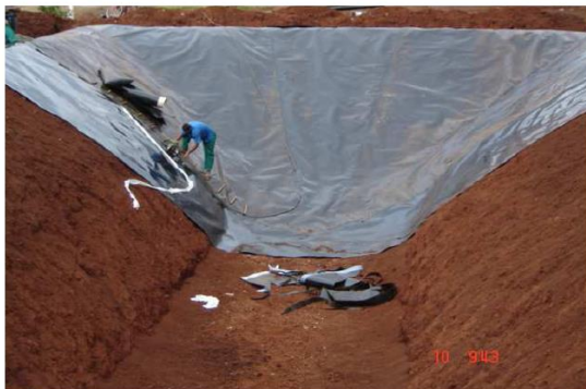
Figura 6 – Colocação da geomembrana de Fundo
