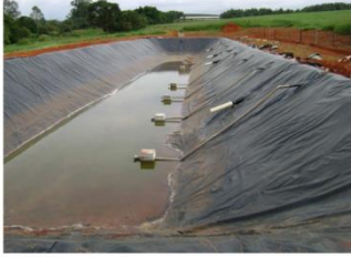
Figura 10 – Sistema de agitação com tubos de pvc e concreto
