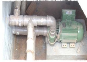
Figura 11 – Bomba para agitação
