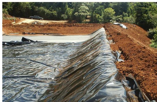
Figura 7 – Ancoragem geomembrana.
