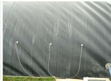
Figura 15 - Sensores de controle da temperatura
