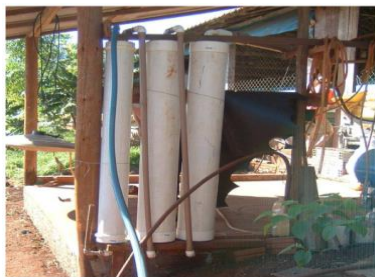
Figura 17 - Filtragem com limalha de ferro
